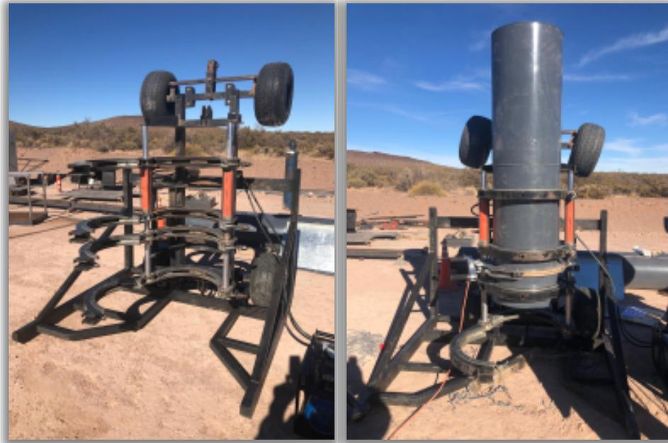
Se ha adaptado el sistema tradicional de fusión a tope para realizarlo de forma vertical, sobre el pozo de perforación con las mismas garantías que la forma tradicional.
